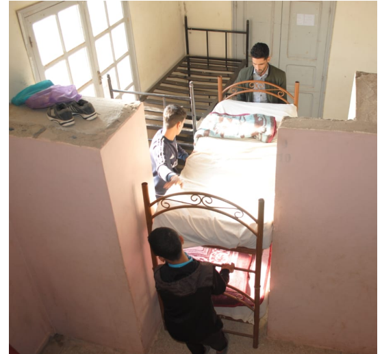
Der renovierte Schlafsaal wird möbliert.
